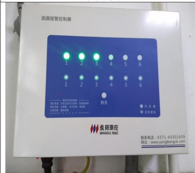
油罐渗漏检测
